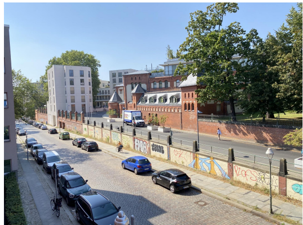
Blick zur Straße
